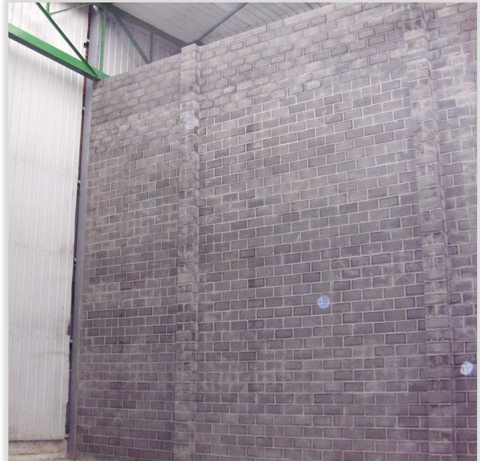
MUROS MEDIANEROS, ejecutados con bloques de hormigón elaborados con áridos siderúrgicos. RF-180
