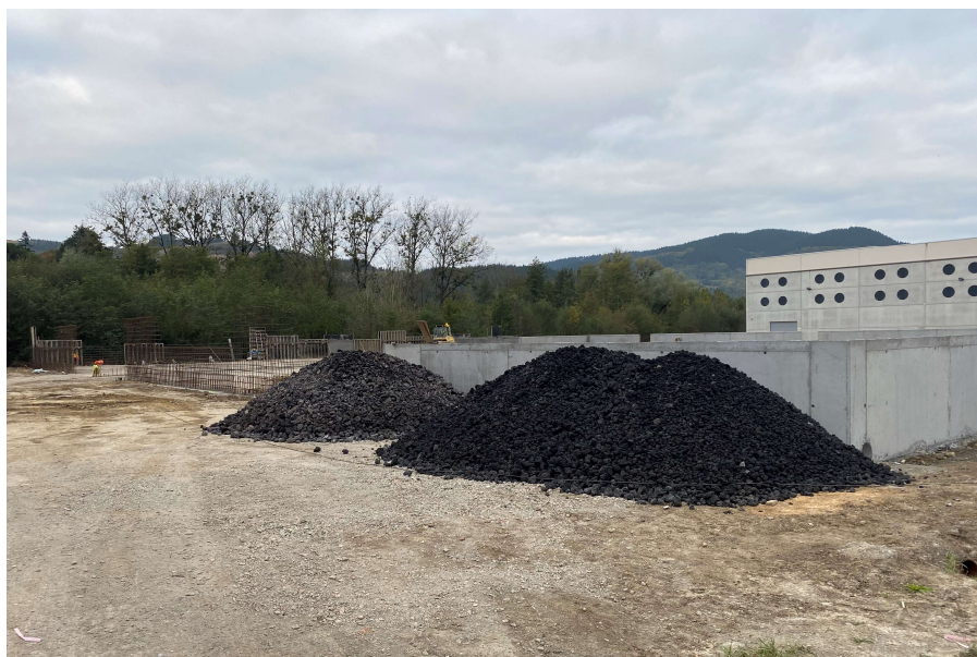
Acopios de áridos reciclados. (áridos siderúrgicos)
