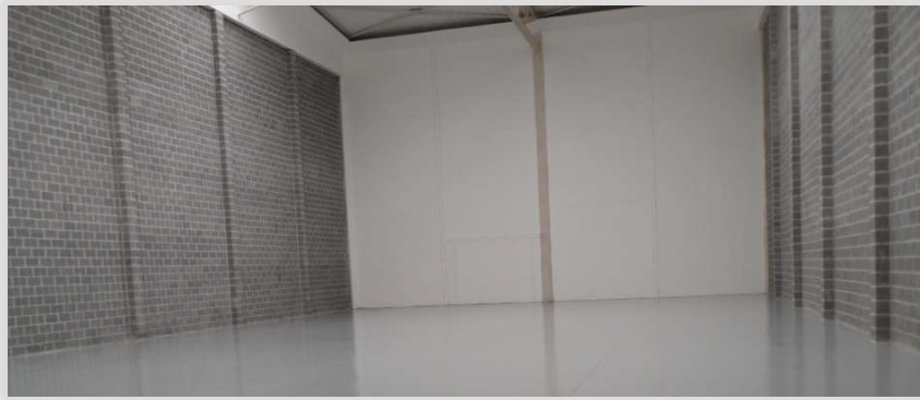
MUROS MEDIANEROS, ejecutados con bloques de hormigón elaborados con áridos siderúrgicos. RF-180
